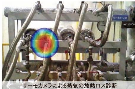
サーモカメラによる蒸気の放熱ロス診断
